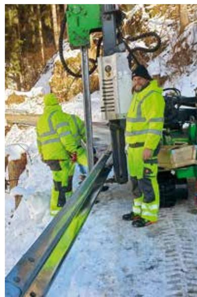
Zur Erhöhung der allgemeinen Verkehrssicherheit wurden an einem Teilstück der Waitschacher Straße im Auftrag der Gemeinde von der Fa. NORDLAND-Hydraulik GmbH neue Leitschienen montiert. Im Zuge dieser Arbeiten wurden auch bei der Ratteingraben Straße im Bereich der sanierten Straßenabrutschung die vorhandenen Leitschienen um ca. 10 Meter verlängert.
