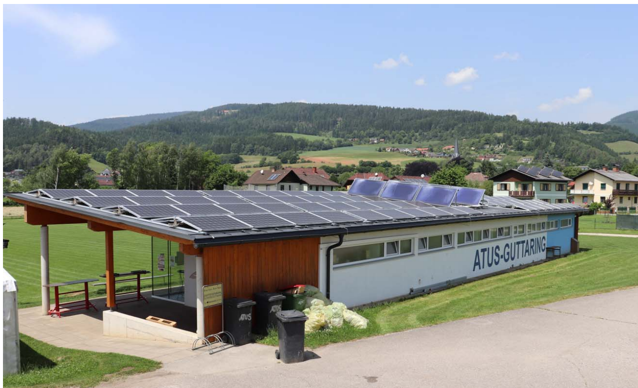
Abbildung 3: Sportanlage Guttaring @Christian Goritschnig
